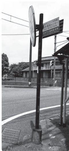
撤去される予定のカーブミラー
