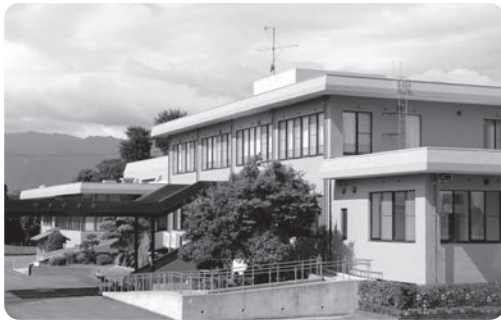
改修工事中のやすらぎ苑
