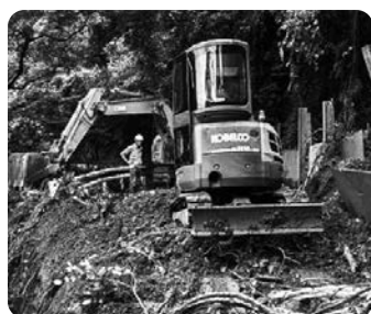
災害時には地元土木業者が早急に対応
