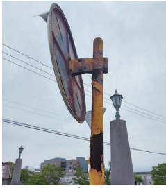
▲修繕などを行い、安全性を確保します
