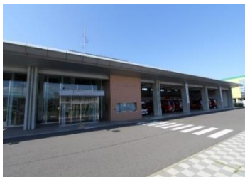
西消防署庁舎建設
