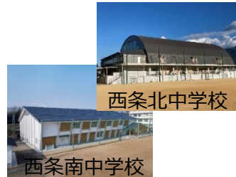
中学校屋内運動場等整備
