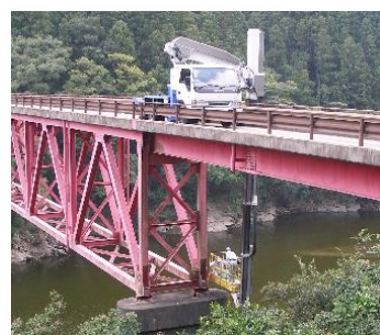
点検車による点検
