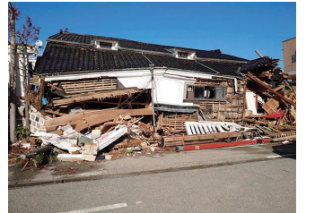
能登半島地震による被害
