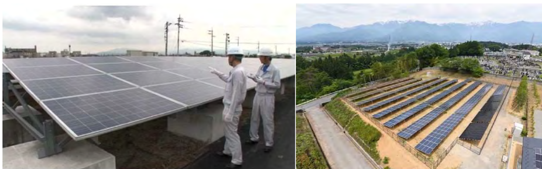
太陽電池モジュールの外観検査
