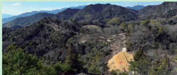
⑧ 尾根に沿って築かれた城壁を確認!
