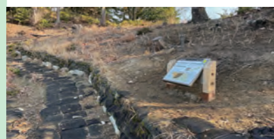
③ 城壁を知ろう!(南西部城壁)
