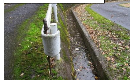
グラウンド南側水路 清掃後
