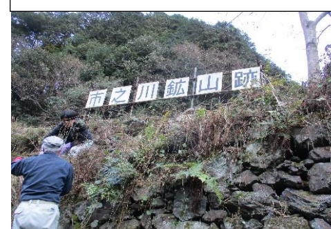
看板の下部の草刈り作業
