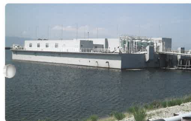
排水処理施設
