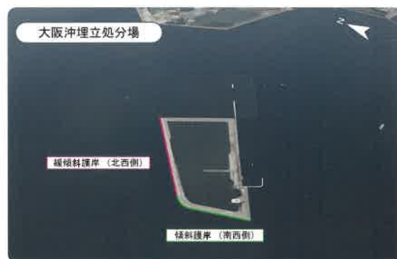
緩傾斜護岸と傾斜護岸の設置箇所
