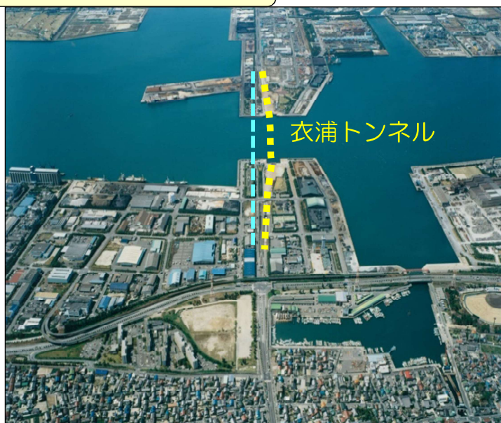
衣浦トンネル4車線化（平成15年開通）
