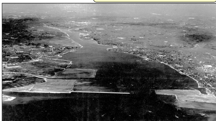
中央ふ頭工事の全景 (昭和40年)
