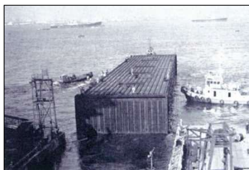
衣浦トンネル沈埋函の進水 （昭和46年）
