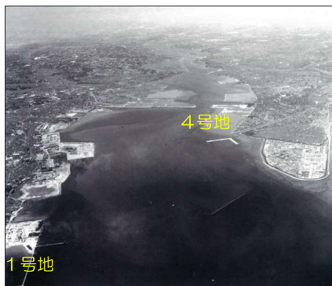
衣浦港全景 (昭和41年)
