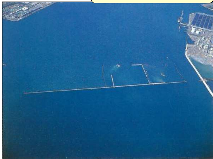
廃棄物護岸着工時（平成6年）
