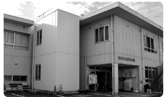
玄関横にエレベーターを増設した玉津公民館
