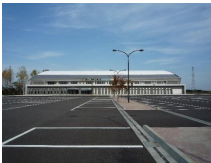
東予運動公園整備
