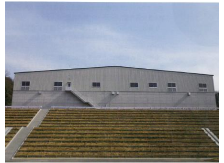
東部一般廃棄物 最終処分場整備
