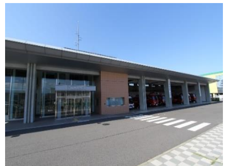
西消防署庁舎建設
