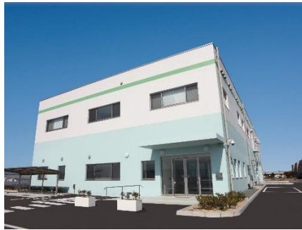
ひうちクリーンセンター整備
