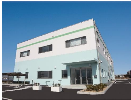
ひうちクリーンセンター整備
