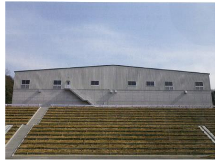
東部一般廃棄物 最終処分場整備
