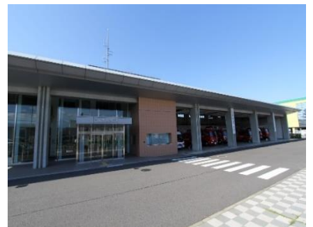
西消防署庁舎建設
