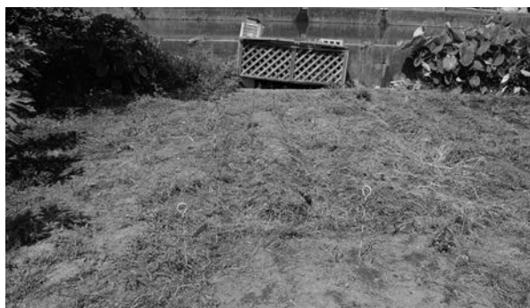
写真3-1 トレンチ設置状況
