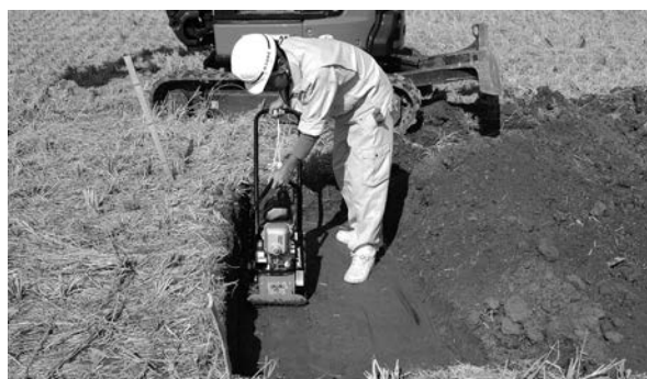
写真3-4 埋め戻し（ランマによる転圧）状況
