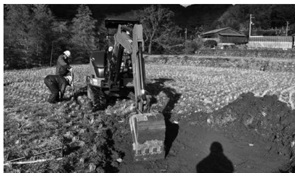
写真3-2 重機による掘削状況
