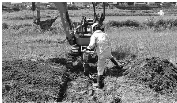
写真5 埋め戻し（ランマによる転圧）状況
