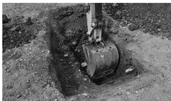
写真3 重機による掘削状況
