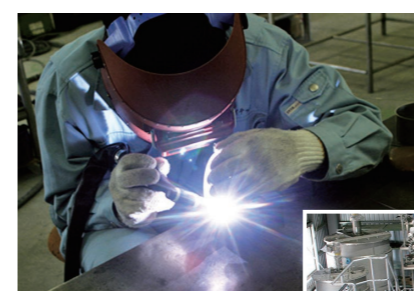
製缶・配管の様子
