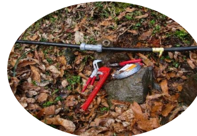
継手の取替
