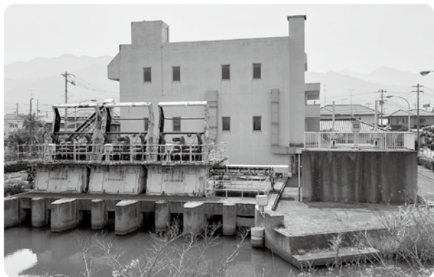
船屋ポンプ場
