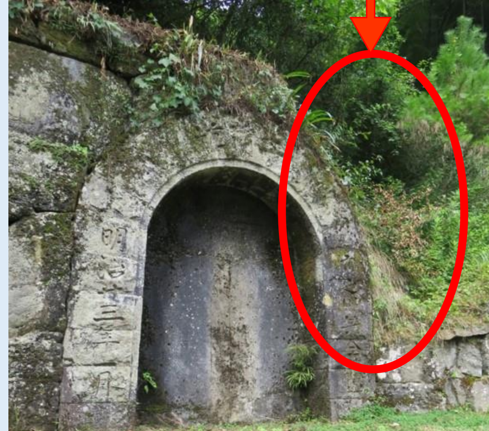
現在の千荷坑の様子
