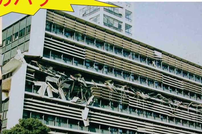
被災した神戸市役所(6階部分が倒壊)
