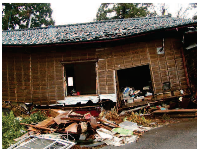
新潟県中越地震で1階が潰れた家屋
