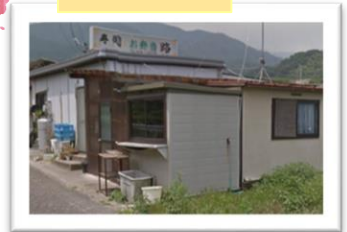
④仕出し屋
