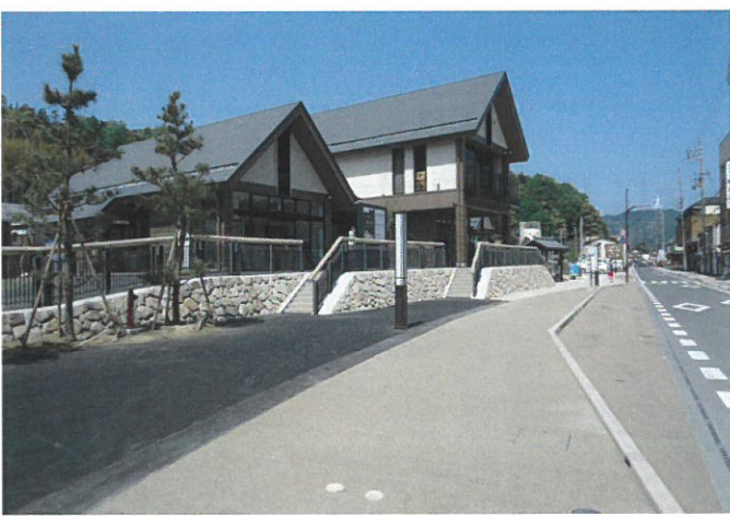
整備後（竣工：平成27年5月）
