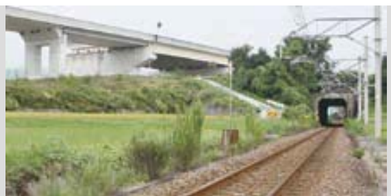
大明神川の土手に見える開口部が河床トンネルの証拠です
