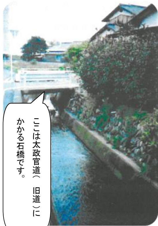
写真左：改修された姥橋と若水川(檜木と野々市の境)
