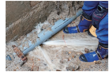
▲経年劣化で漏水している水道管
