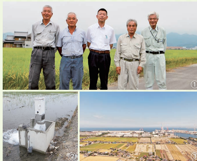
①農業組合法人ファーム北条の皆さん ②整備した自動給水栓。管理も手軽に ③工事中の状況
