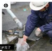
⑫ 洗浄作業が完了
