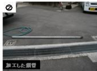
② 加工した鋼管
