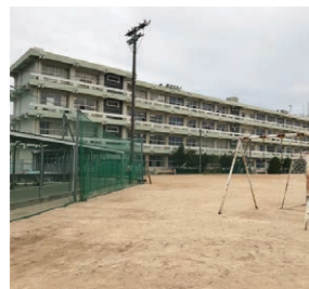
▲両小学校、令和4年度に改修完了予定
