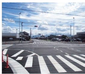
▲令和3年3月から部分供用を開始しています
