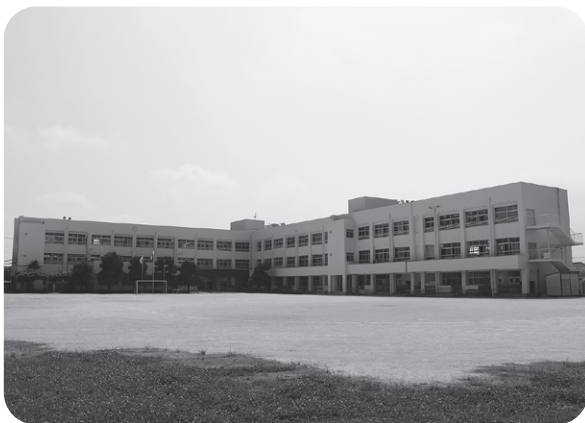
改修予定の丹原小学校
