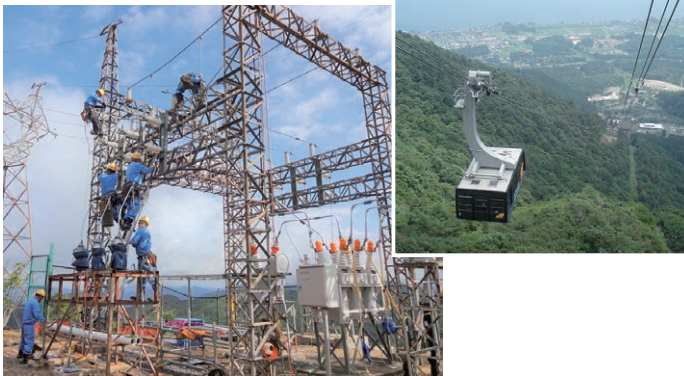
▲設備の新設・更新では高所での作業も
