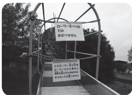
使用禁止となっている遊具
