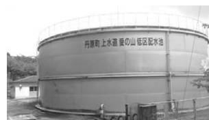
2,200 m 3 の水道水を貯水できる愛の山低区排水池
