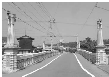
市道中央線にかかる小松橋
