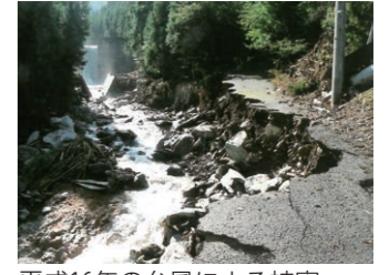
平成16年の台風による被害
