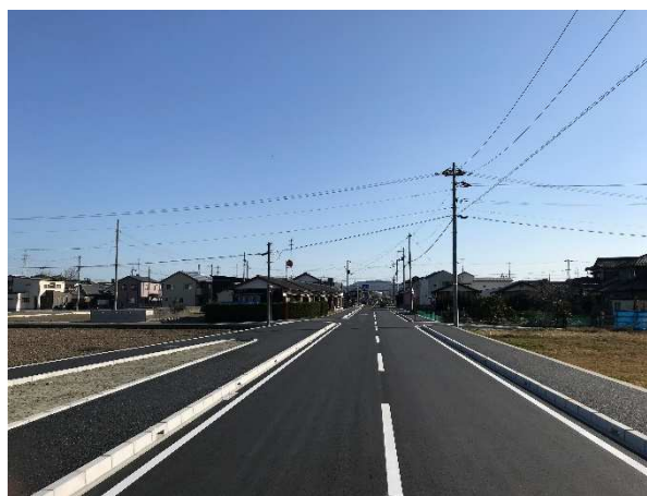
県道西条港線から西に約200m地点 ※ 令和3年3月初旬に東方向を撮影した写真
