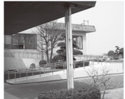
▲完成したスロープ
