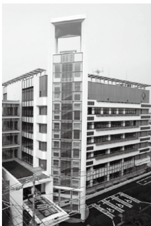
完成した市庁舎新館
