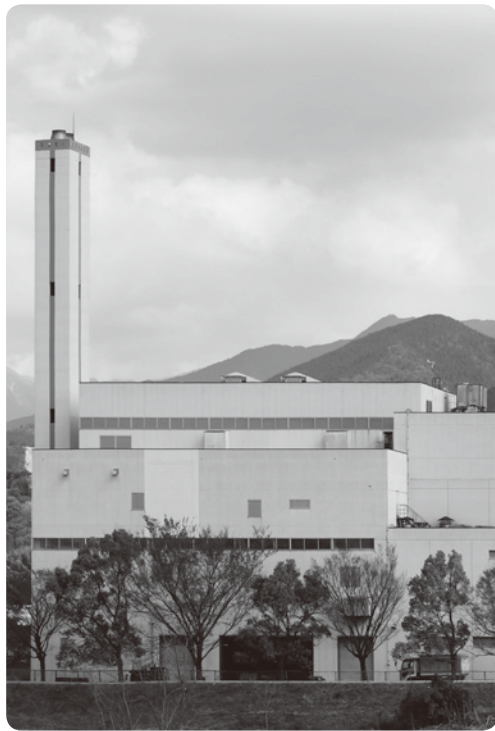
基幹的設備改良を行う道前クリーンセンター
