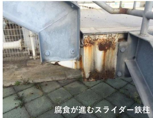
腐食が進むスライダー鉄柱
