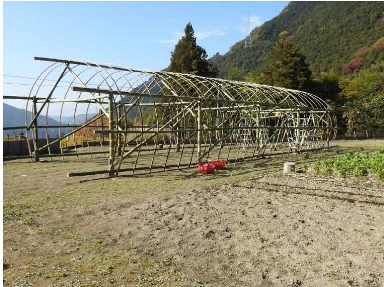
図 2 完成した竹を用いたビニールハウス（間口 4.6m, 奥行 15m, 棟高 3m）
