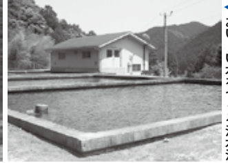
おいしい水をつくる浄水池
