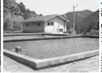
おいしい水をつくる浄水池
