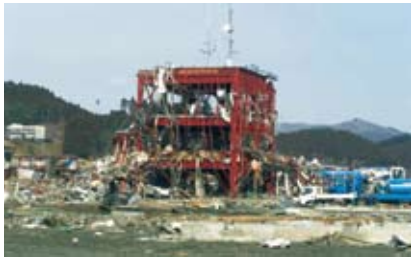
▲南三陸町：南三陸町役場防災対策庁舎
