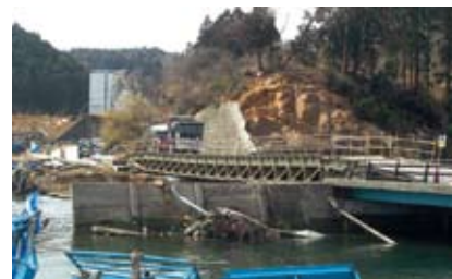
▲南三陸町：自衛隊が設置した仮設橋
