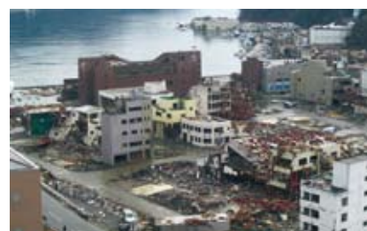
▲女川町：残された建物にも大きな被害が
