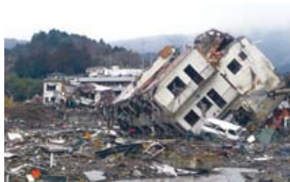
▲女川町：津波で倒された建物
