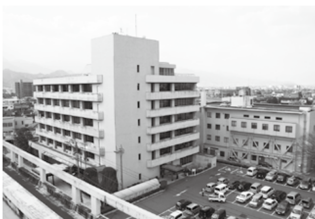
▲合併以降の懸案となっていた新庁舎建設に着手します。 (写真：昭和54年に建設された現在の西条市庁舎本館)
