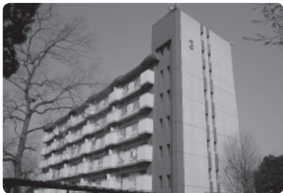
今後外壁の改修を行う予定の玉津団地
