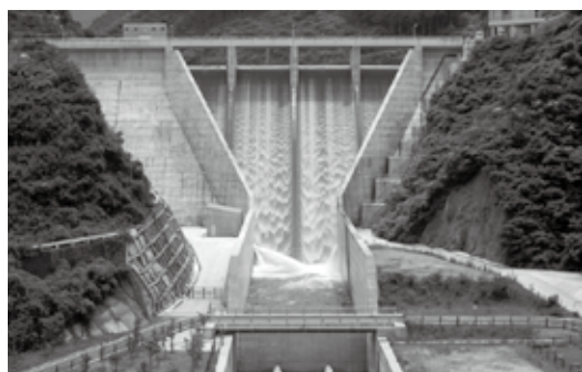
▲試験湛水期間中に越流する志河川ダム
