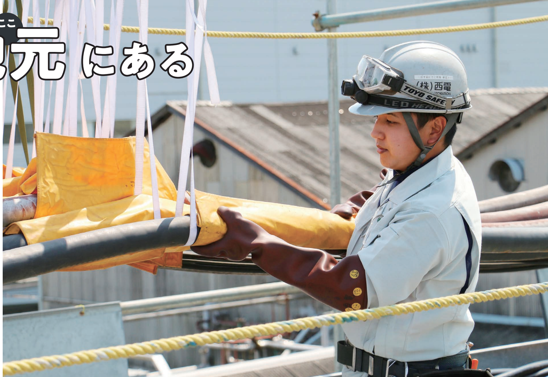
▲地上4～5m。劣化したラック（台）の交換作業。
