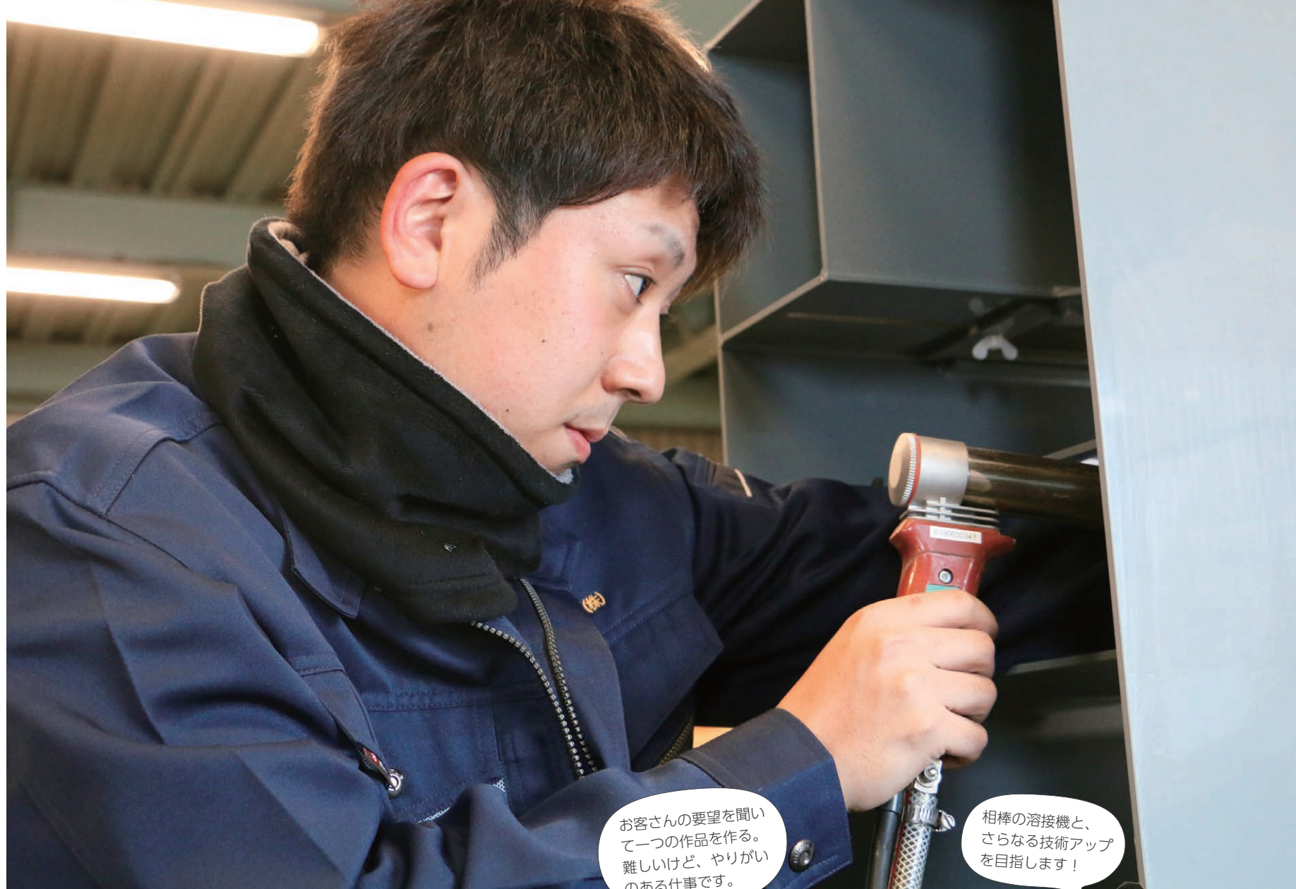
▲難しい隅の溶接。真剣なまなざしで集中！
