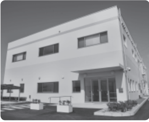
更新されたひうちクリーンセンター
