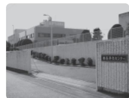
公共下水道事業で運営されている西条浄化センター
