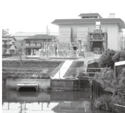
▲本河原ポンプ場
